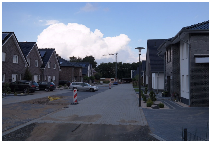
Der Johannisbeerweg ist bereits so gut wie fertiggestellt.
