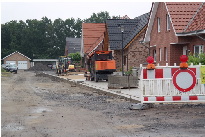
Blick in den Heidelbergweg, hier sind die Bauarbeiten in vollem Gange.
