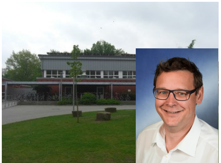
Die kleine Turnhalle ist nun wieder einsatzbereit.
